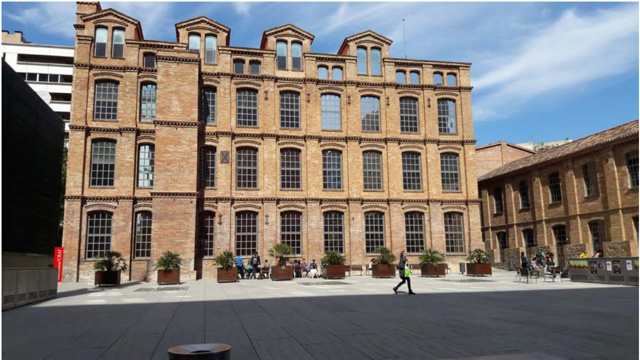
Figura 5b. Antoni Vilanova y Eduard Simó. Rehabilitación de la antigua textil Ca' Aranyó como sede del Campus de la Comunicación de la Universidad Pompeu Fabra. Barcelona (2003-2008) (Fotografía Á. Layuno).
