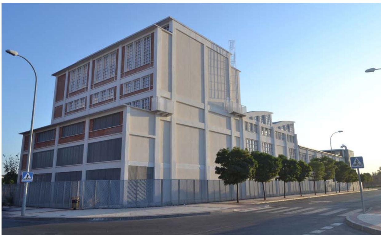
Figura 6c. Estudio Aranguren & Gallegos. Proyecto de consolidación y rehabilitación de la antigua fábrica Gal (2010). Tratamiento exterior de la fachada Norte. La solución de enfoscado con mortero monocapa destaca por la sinceridad con que se afronta el problema, al no buscar recrear lo inexistente, sino expresar el carácter neutro y silencioso de un acabado que cicatriza el corte estructural efectuado en el derribo (Fotografía Á. Layuno).
