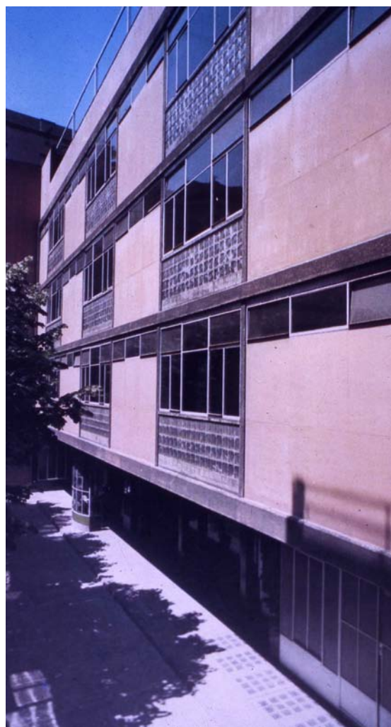
Figura 2. Barcelona. Dispensario Antituberculosos (1934-1935). Sert, Torres-Clavé y Subirana. Restaurado en 1990 por los arquitectos M. Correa, E. Mannino y R. Torres (Fotografía J. Rivera, 1990).
